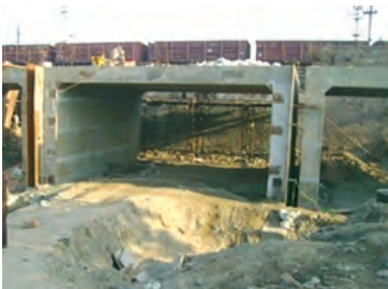
चित्र 7: बक्सों का निर्माण
