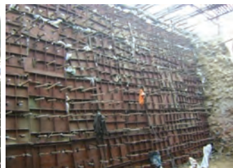
चित्र 12: पूरी दीवार पर कीलन की प्रक्रिया
