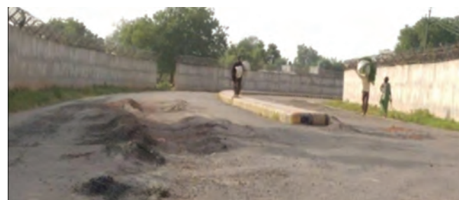
चित्र 1 सड़क में रटिंग व शोविंग प्रक्रिया चित्र 2 सड़क में हुई रेबलिंग व क्रैकिंग चित्र 3 सड़क में रटिंग, क्रैकिंग व शोविंग
