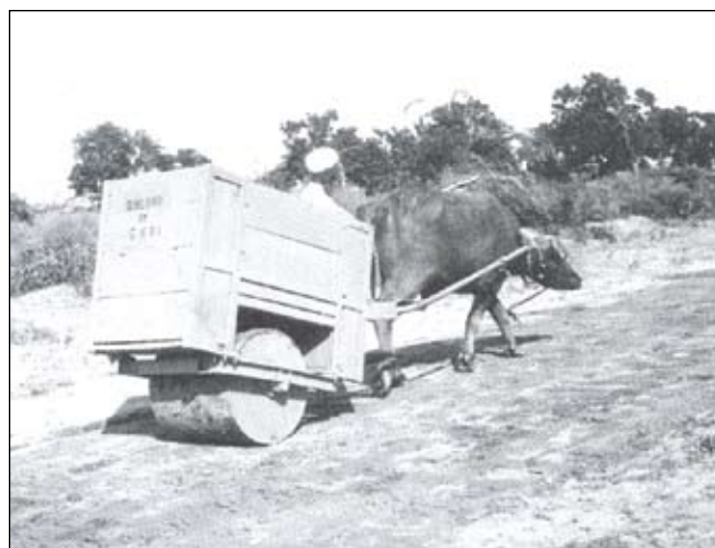
चित्र 2 : ग्रामीण सड़क निर्माण के लिए पशु द्वारा खींचा जाने वाला रोड रोलर
