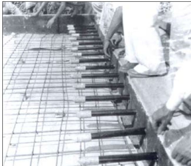
चित्र 1 : भेल, भोपाल क्षेत्र में डॉवल बार सहित कंक्रीट पट्टों का निर्माण
