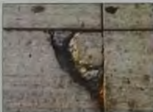
Fig. 55 Longitudinal crack
